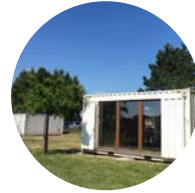
Aménagement de container
